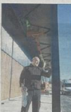
L'ère est aux retouches peintures sur la charpente métallique.
