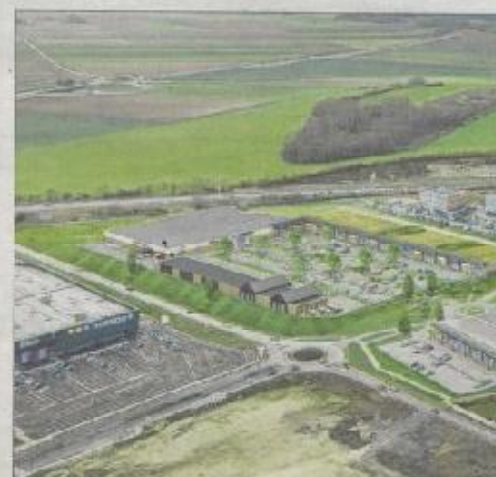
Voilà à quoi ressemblera l'ensemble commercial dans quelques mois. D'ici là...
